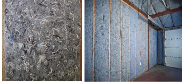
Şekil 1. Pamuktan (Geri Dönüştürülmüş) Yapılan Panel Yalıtım Uygulaması (Asdrubali F. et al, 2015)
