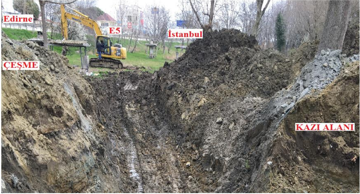
Şekil 9. Çalışma alanında yapılan kazıdan bir görüntü.
